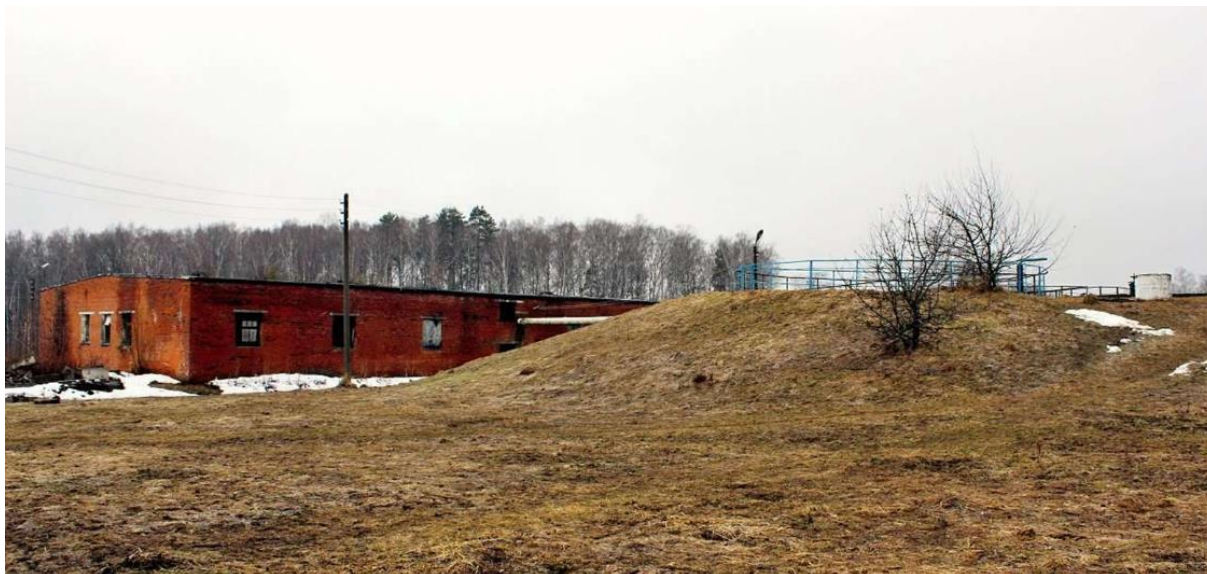
Рисунок 2. Территория очистных сооружений
